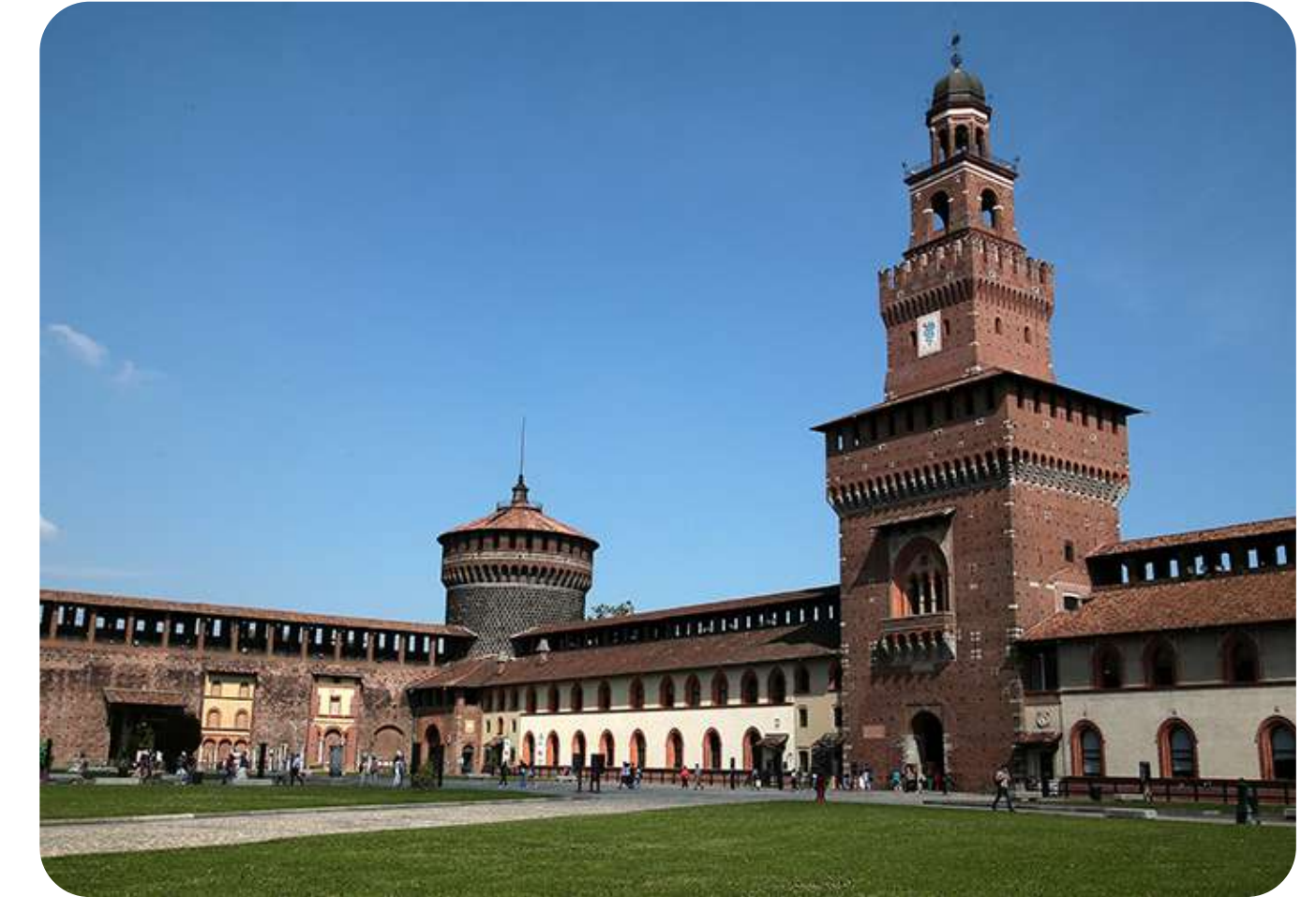
CASTELLO SFORZESCO The Sforza Castle
